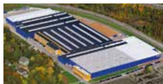
Hörmann KG Eckelhausen, Allemagne
